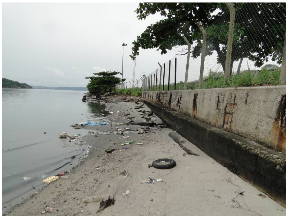
Figura II.3-6– Vista do trecho de aterro sem contenção.
